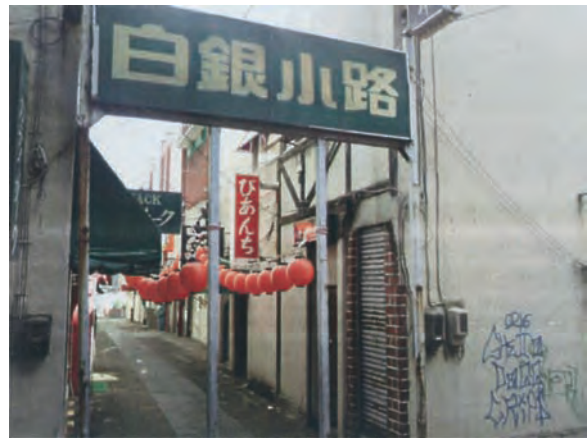
図 2 落書き（建物の壁）の例
