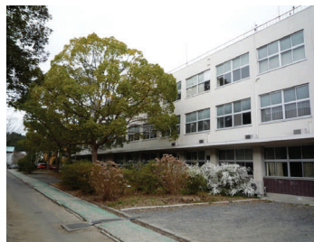
改修工事前の電気工学科棟 クスノキとユキヤナギ
